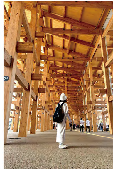
大阪・関西万博 大屋根リング
